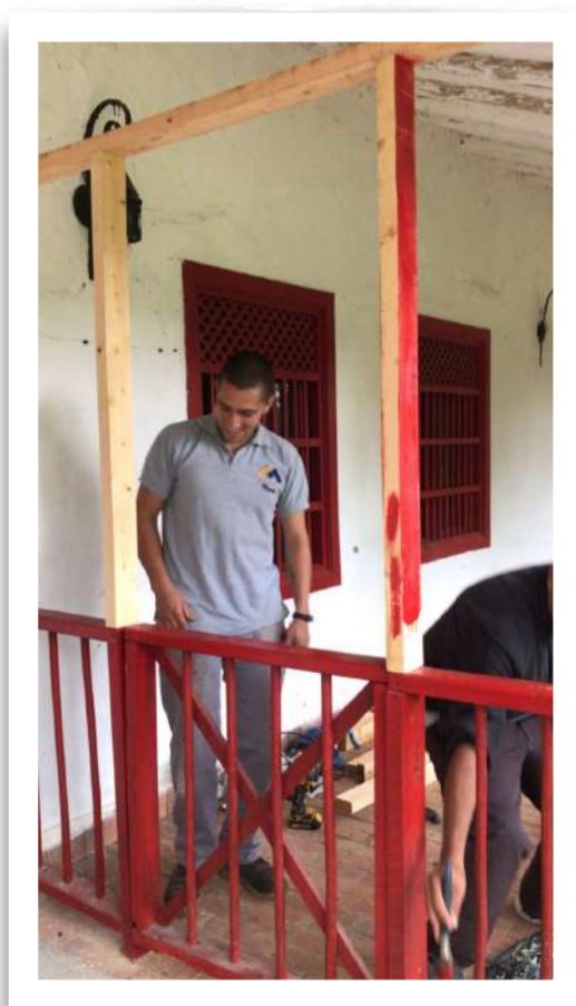
Inicio de aislamiento pasillos
