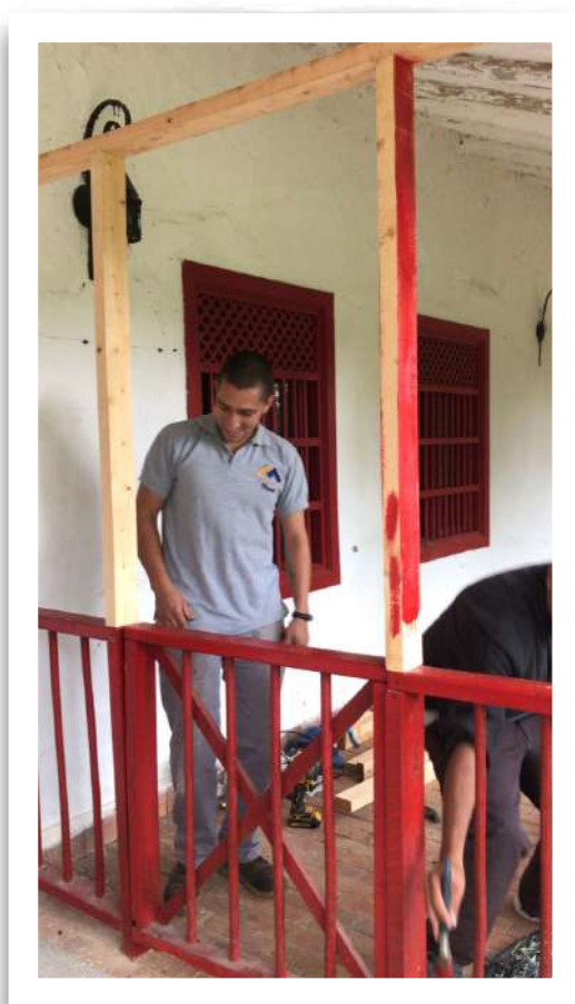
Inicio de aislamiento pasillos
